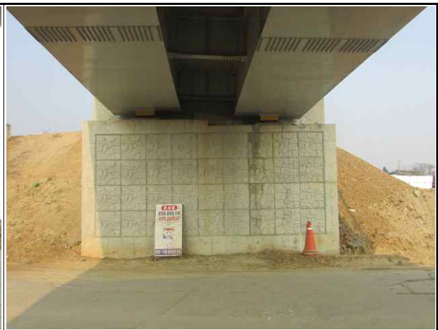
교대 A2 전경
