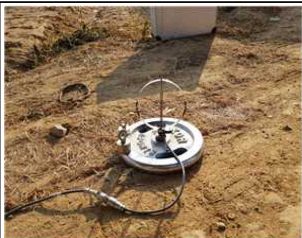
치짐계 설치 현황
