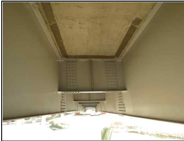
강재 가로보 상태양호
