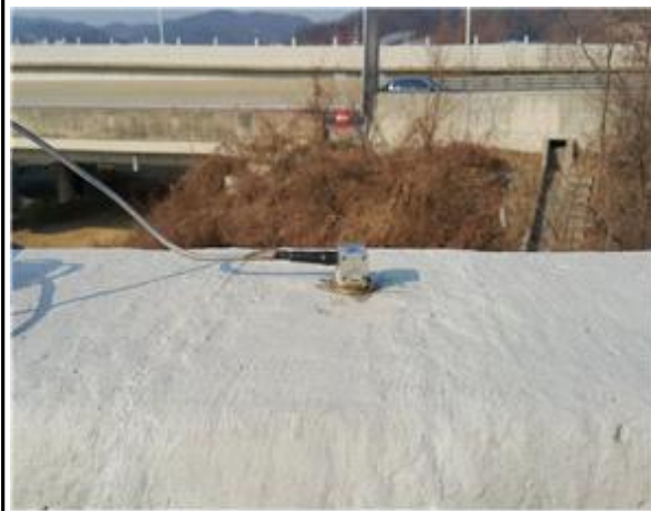
가속도계 설치 현황
