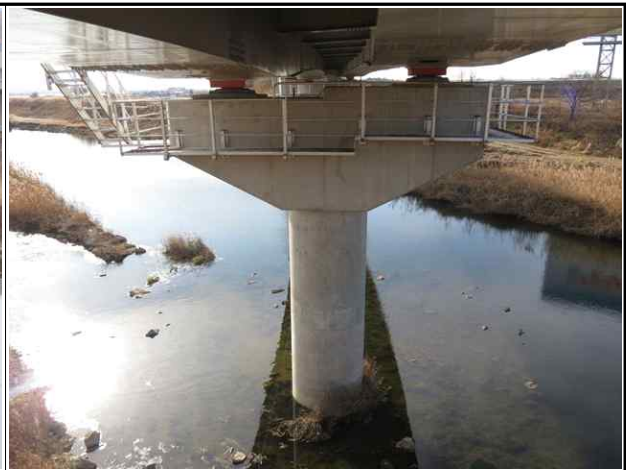
교각 P2 전경
