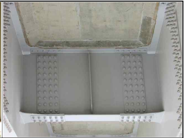
강재 가로보 상태양호
