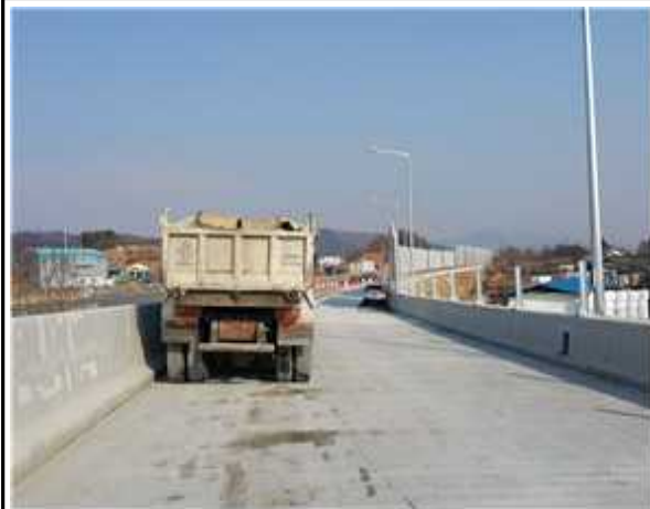
정적 재하시험 전경
