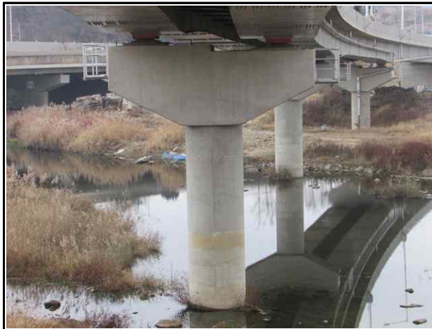
교각 P1 전경
