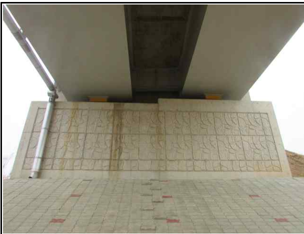
교대 A1 전경
